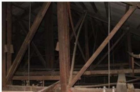
机械加固木桁架的钢吊件
