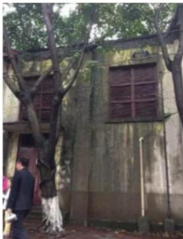
室外墙面被雨水侵蚀墙面污损
